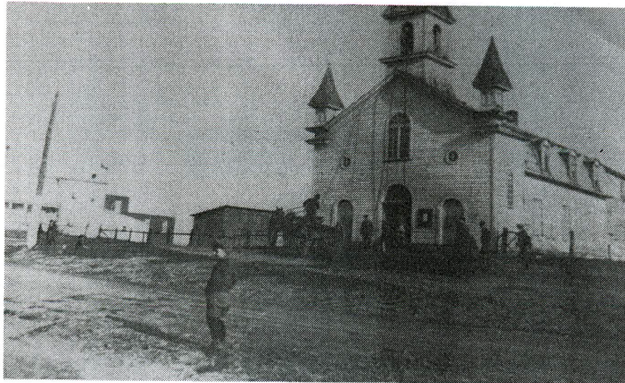
Descente de la cloche de la chapelle pour l'installer dans l'église neuve.
