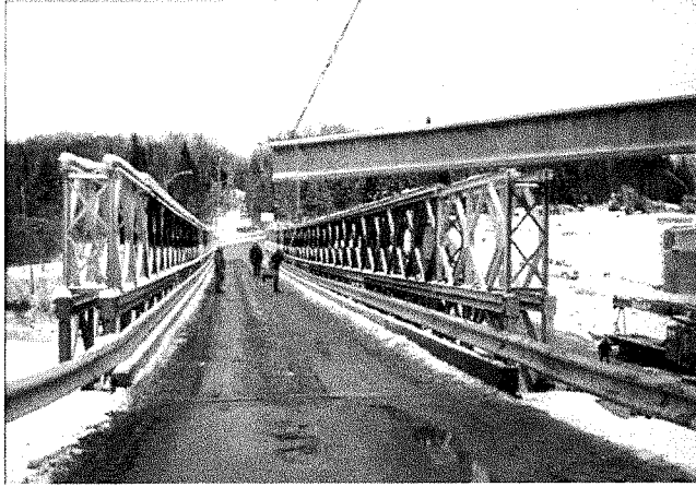
(Photos de décembre 2000 : à gauche, pont Bailey; à droite, une poutre de 75 tonnes qui sert à l'érection du nouveau pont situé à la droite de l'autre)
