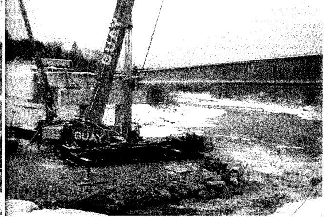
(Photos de décembre 2000 : à gauche, pont Bailey; à droite, une poutre de 75 tonnes qui sert à l'érection du nouveau pont situé à la droite de l'autre)
